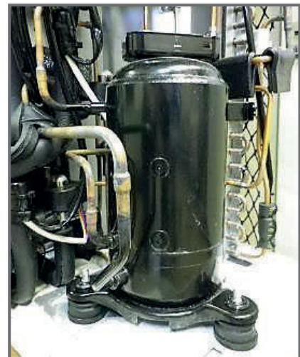
Abschließender Zustand mit ausgewechseltem Kompressor
